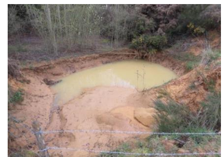
Bassin d'infiltration des eaux de ruissellement du site (© OUEST AM')
