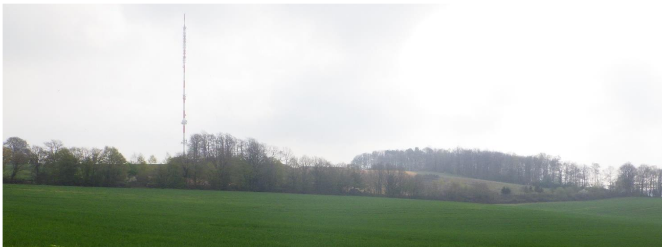
Merlon paysager qui limite la vue de l'excavation depuis le hameau de la Barre au Cottereau
