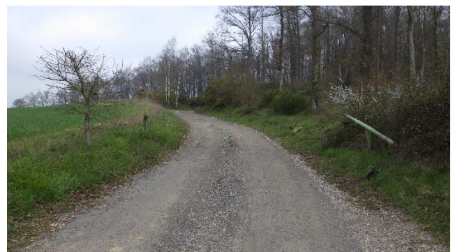
Accès à la carrière clôturée par une barrière de sécurité
