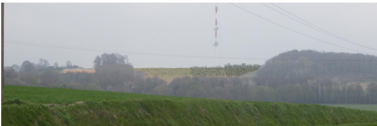
Photosimulation des effets de l'exploitation de la carrière début de phase 3 (T+10ans) : seul un secteur au Nord reste à extraire. Les fronts exploités sur la partie Ouest sont totalement remis en état et les perceptions visuelles sont intégralement résorbées.
