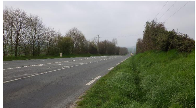
Vue du côté Ouest de la RD 923 en direction de Nogent-le-Rotrou
